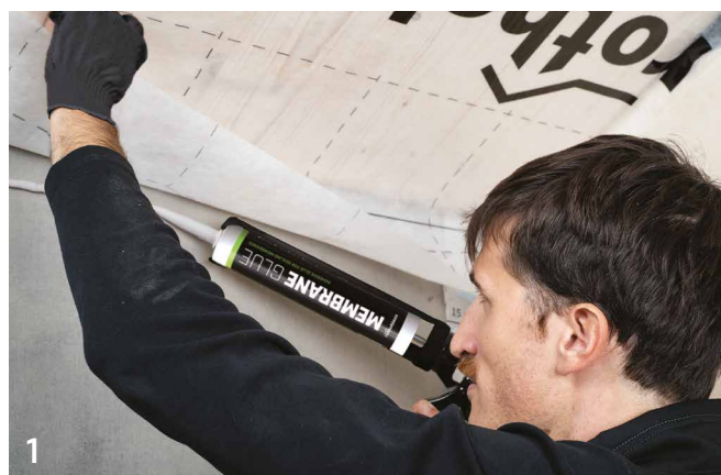
POŁĄCZENIE MEMBRANY Z POKRYCIEM - BETON
